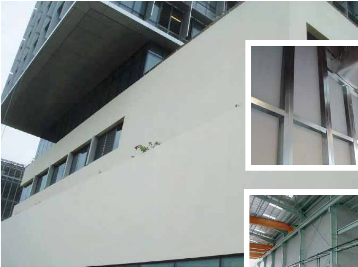
Desde arriba, en sentido horario: Revestimiento de muros exteriores PROMINA® -HD en el hospital K hoo Teck Puat en Yishun, Partición con placas de fibrosilicato PROMATECT®-H en New Tech park, y revestimiento de muros exteriores PROMINA® 60 en bodega en Gul Road. Todos los proyectos ubicados en Singapur.
