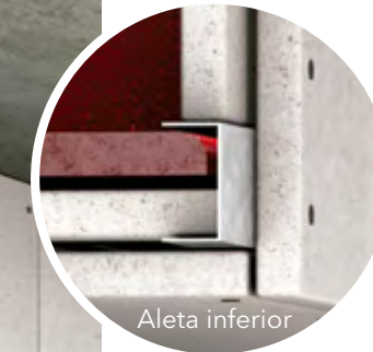
Fijación opcional de canales de tres lados
