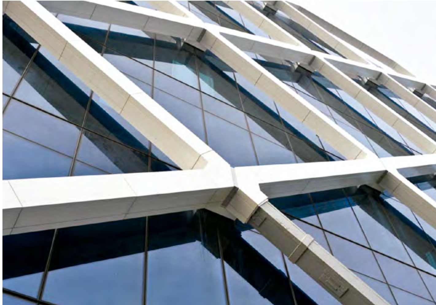
Revestimiento de columna y viga de acero estructural PROMATECT®-H en el edificio de oficinas One Shelley Street (arriba) en Sydney, Australia y Tatan Power Point, Taiwán (izquierda).
