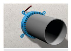
**4.** Bohrlöcher zur Befestigung der Brandschutzmanschette sind zu markieren.
