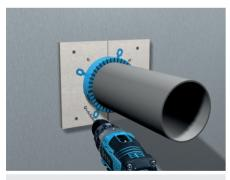
**7.** Ø4mm Löcher sind in der PROMATECT®-100 Brandschutzplatte und im Blech vorzubohren. Danach kann die Brandschutzmanschette mit den beiliegenden Schrauben befestigt werden.
