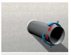
**3.** Die Brandschutzmanschette ist um das Rohr zu platzieren und der Verschluss zu schließen. Die Manschettenlasche ist um 180° zu biegen, damit die Manschette an der Wand aufliegt.
