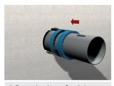
**4.** Der verbundenen Brandschutzmanschetten sind im Anschluss in die flexible Wand zu schieben - dabei muss die Länge des Metallstreifens mindestens 50 mm länger als die Wanddicke sein und je Seite mindestens 25mm vorstehen.
