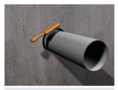
**1.** Das Rohr ist im Bereich der Schottöffnung zu reinigen, um eine glatte und staubfreie Fläche zu bekommen.
