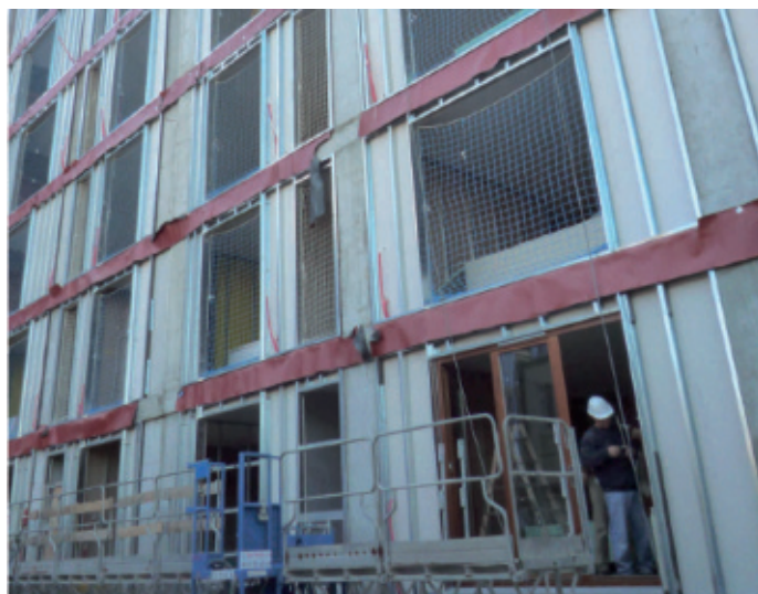
DCW2 y DCW4 Instalación de las placas interiores.
