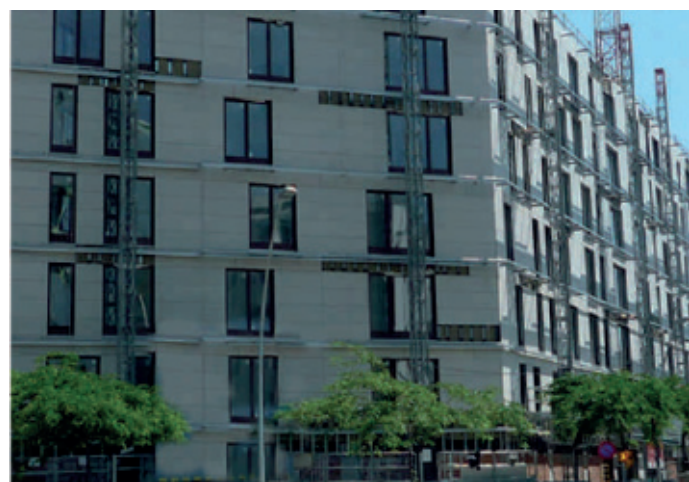
DCW2 y DCW4 Instalación de la lana de aislamiento.
