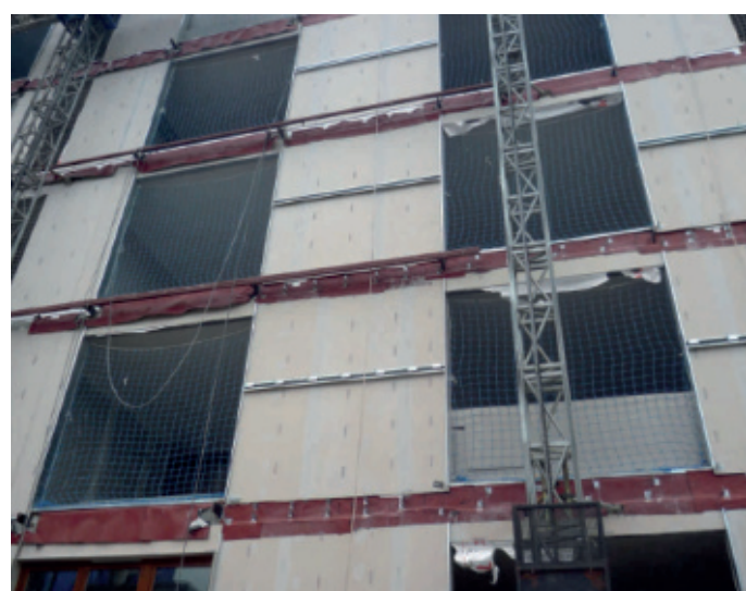
DCW2 y DCW4 Instalación de las placas de exterior.
