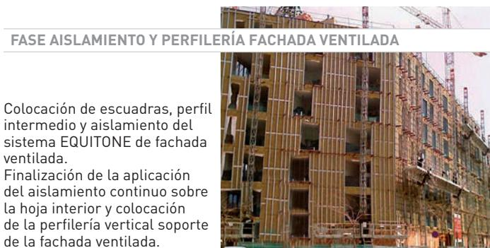
**FASE AISLAMIENTO Y PERFILERÍA FACHADA VENTILADA**
