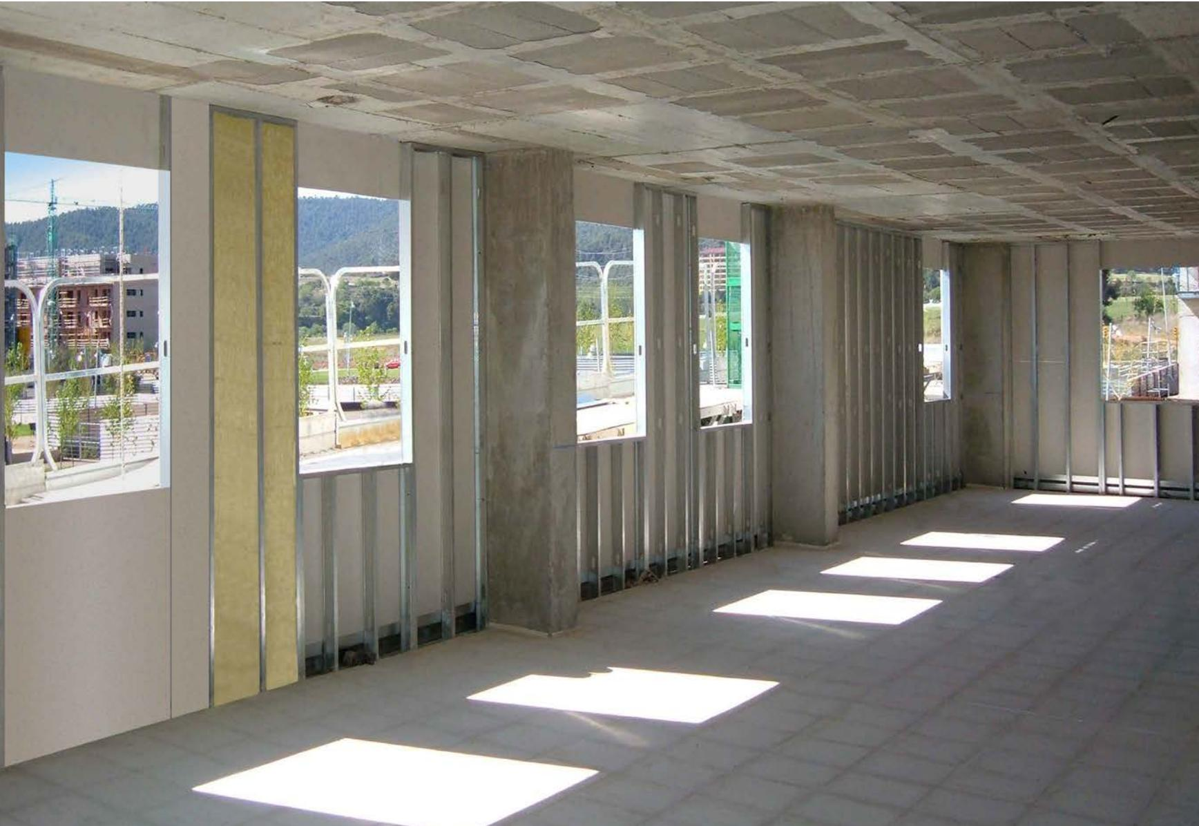
**Cerramiento ligero de fachada.** Sistema de construcción en seco con materiales de altas prestaciones, que dotan a la envolvente del edificio, de mayor eficiencia energética, aprovechamiento del espacio interior y rendimiento que las soluciones tradicionales.
