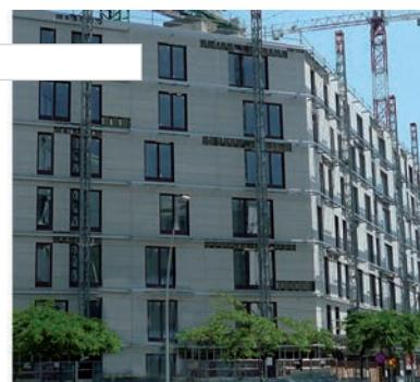
Instalación de la placa EQUITONE seleccionada en proyecto haciendo los remates con huecos, esquinas y coronación de proyecto. Terminación de la fachada realizada íntegramente con paneles y sistemas de Promat.
