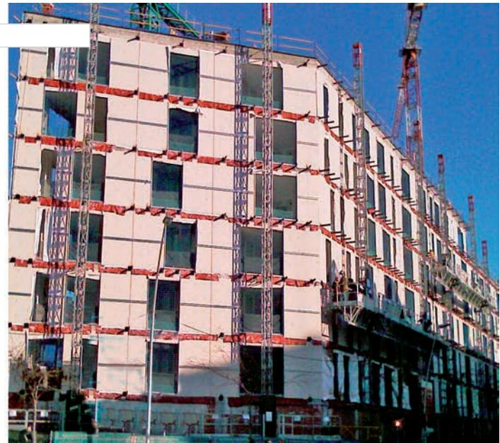
Aplacado exterior con HYDROPANEL de 12 mm y relleno de la periferia con la lana de roca e instalación de dos placas de cartón yeso.
