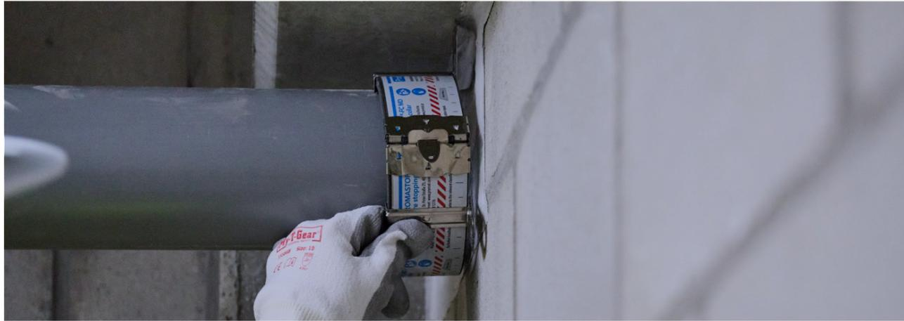
Los sistema se sellado de pasos de instalaciones suele ser la parte más crítica de un proyecto de protección pasiva contra incendios. Una vez que la estructura portante del edificio ha sido protegida y se han instalado los compartimentos resistentes al fuego, todo parece estar preparado para que el edificio pueda salvar vidas en caso de incendio. ¿O no?
