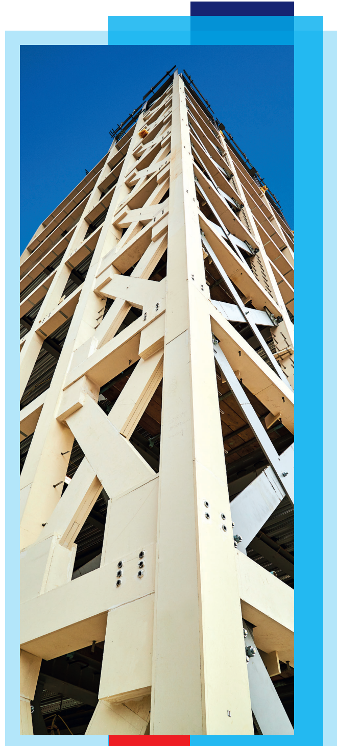
PROMATECT®-XS kan monteras innan byggnaden är vind och vattentät 1 .
