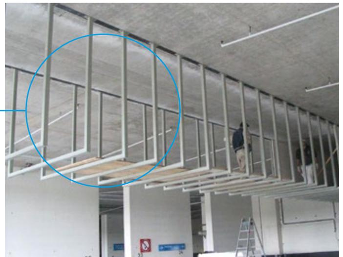
Abb. 1: dreiseitige Ausführungsvariante als luftführender Schacht
