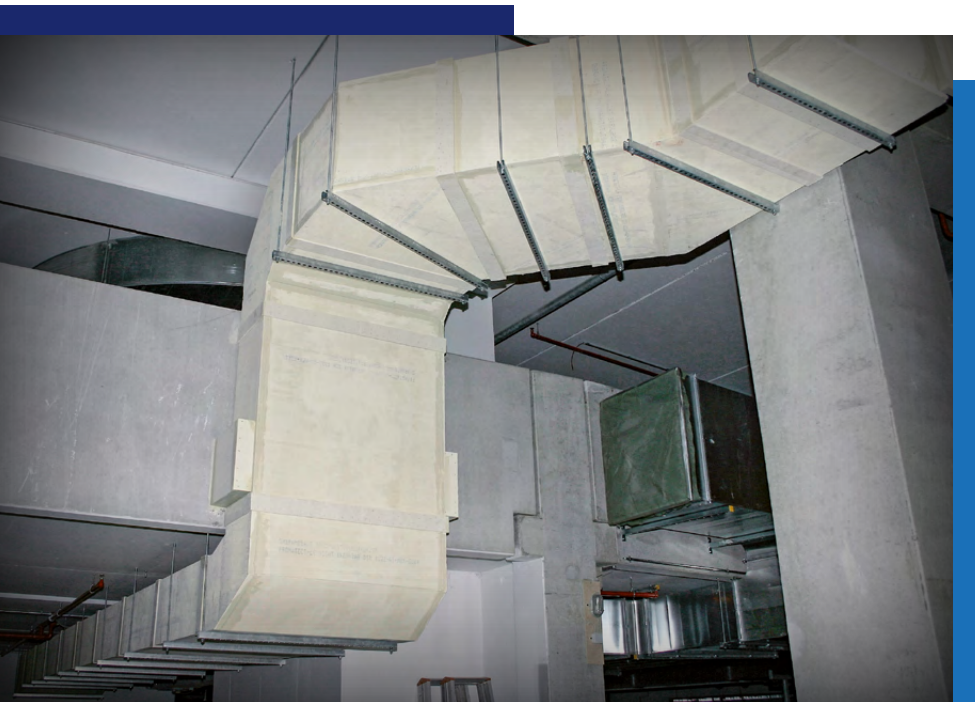
Selbständige PROMATECT®-LS-Lüftungsleitungen
