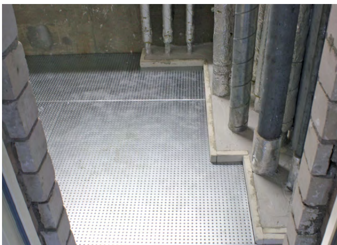
Konstruktion 420.51 Beispiel: begehrbar mit Rohrabschottung
