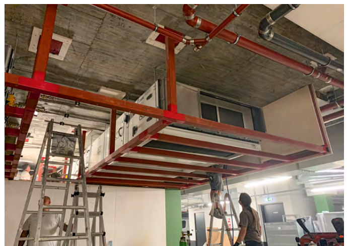
Konstruktion 420.51 Beispiel: als eigener Brandabschnitt für Lüftungsgeräte
