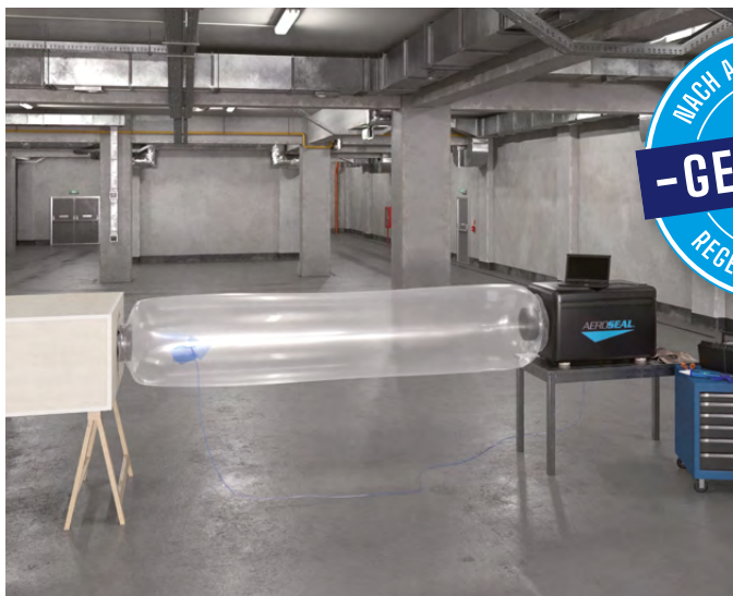
Abdichtung von Leckagen mit dem AEROSEAL®-Verfahren an einem Test-Leitungssystem
