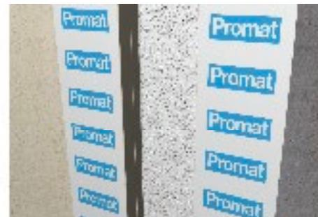
3. Inserte el relleno de la junta (poliestileno o lana mineral de roca acorde a los requisitos del ensayo).
