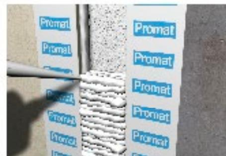
6. Aplique el espesor correcto de sellante (acorde a los requisitos del ensayo).
