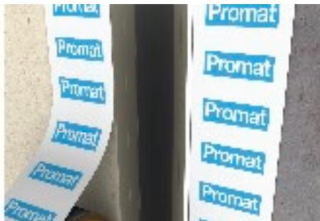
2. Si se requiere, enmascare a 10 mm el exterior de la abertura del muro o losa con cinta.
