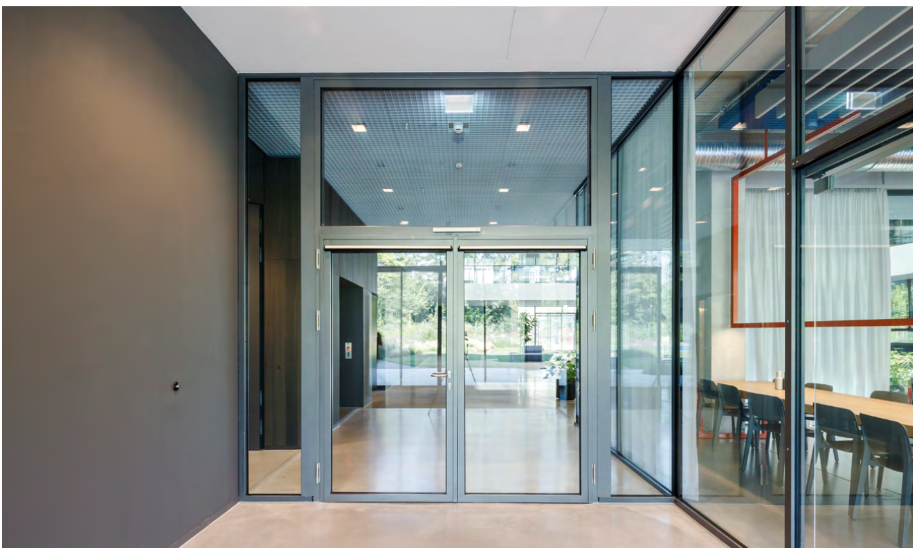
Zweiflügelige PROMAGLAS®-Systemtür 485.36 mit Drehflügelantrieb
