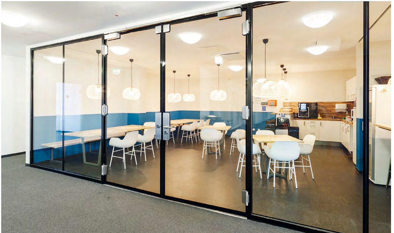
Kombination von zweiflügeliger Promat®-Ganzglastür 385.41 mit Promat®-Ganzglaswand 385.33
