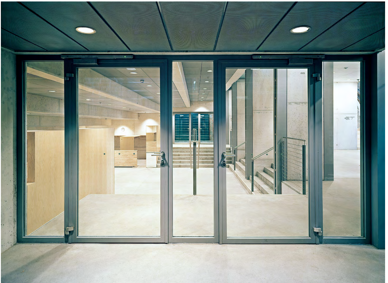
Kombination von zwei einflügeligen PROMAGLAS®-Systemtüren 485.36 mit Glaswand 485.31
