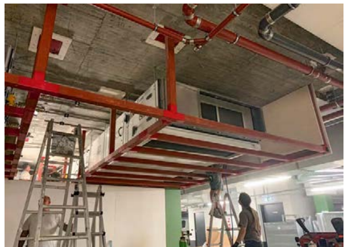
Konstruktion 420.51 Beispiel: als eigener Brandabschnitt für Lüftungsgeräte
