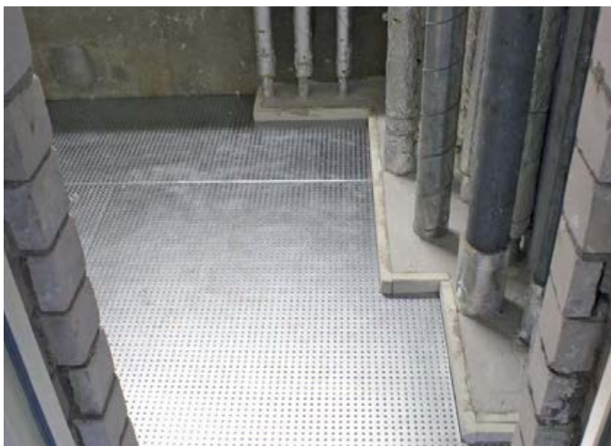
Konstruktion 420.51 Beispiel: begehbar mit Rohrabschottung
