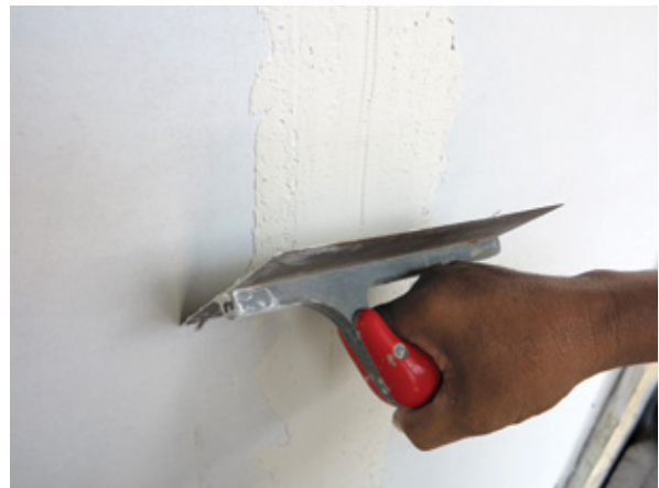
Nanesite dodatni sloj materijala za ispunu spojeva
