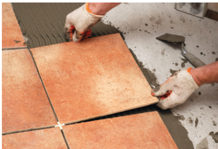
Nanošenje lepka za pločice na montirane Promat ploče pre postavljanja pločica
