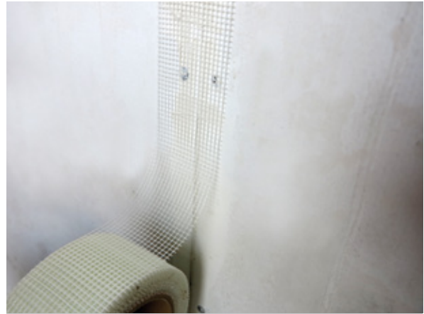
Spoj popunite jednim tankim slojem ispunе za spojeve i nakon toga postavite mrežicu za ojačanje
