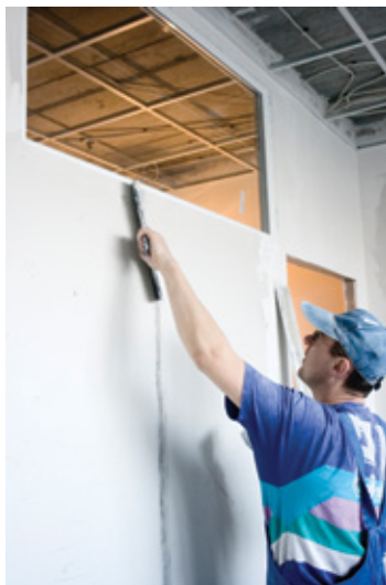
Gletovanje spojeva ploča kod pregrada (gore levo) i spojeva zidova i plafona (gore desno)
