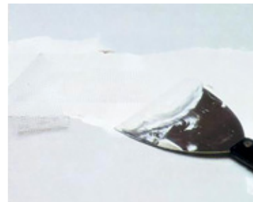
Nanošenje ispune za spojeve
