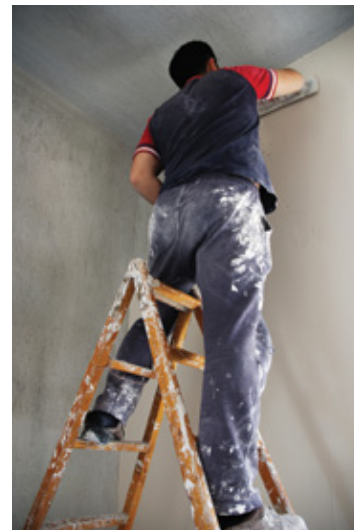
Gletovanje spojeva ploča kod pregrada (gore levo) i spojeva zidova i plafona (gore desno)
