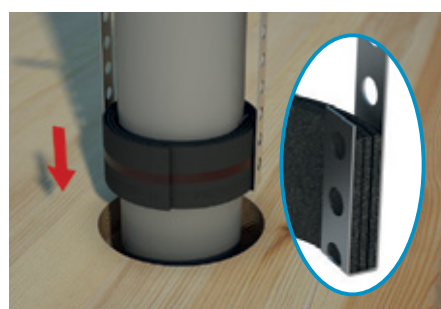
6. Upotrebite perforiranu metalnu traku da biste formirali kuku; postavite dve kuke na traku PROMASTOP®-W tako da obuhvataju čitavu širinu od 50 mm
