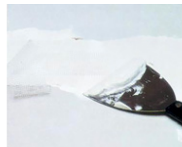
Aplicarea ipsosului de îmbinări
