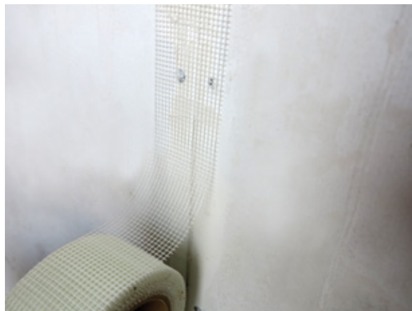
Se aplica un strat subtire de ipsos si apoi se aplica banda de imbinare.
