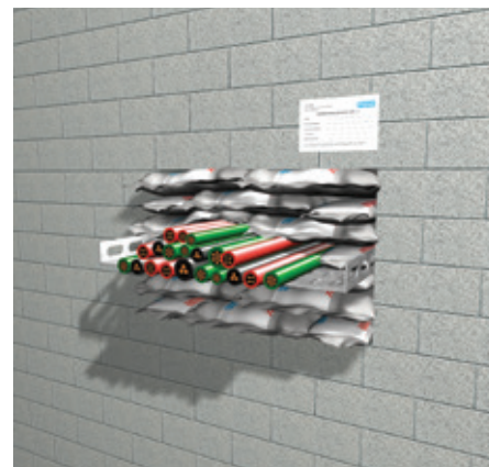
5. Stavite identifikacijsku naljepnicu na prikladno mjesto.
