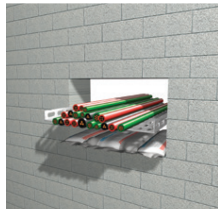
3. Prvi sloj jastučića treba postaviti ispod kablova i/ili cijevi.
