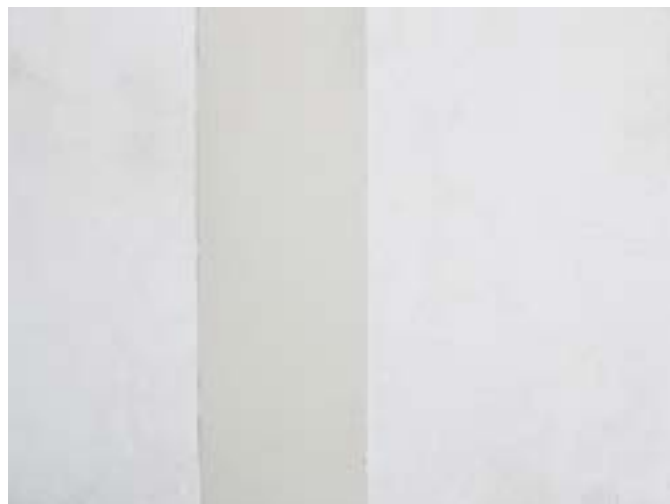
Złącze po finalnym wykończeniu pacą
