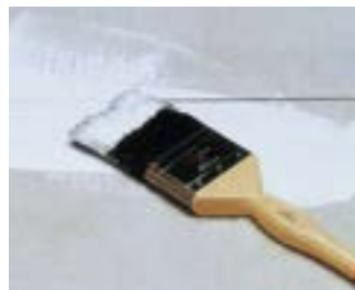
Przygotowanie złącza z pomocą gruntu
