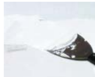
Nakładanie masy szpachlowej
