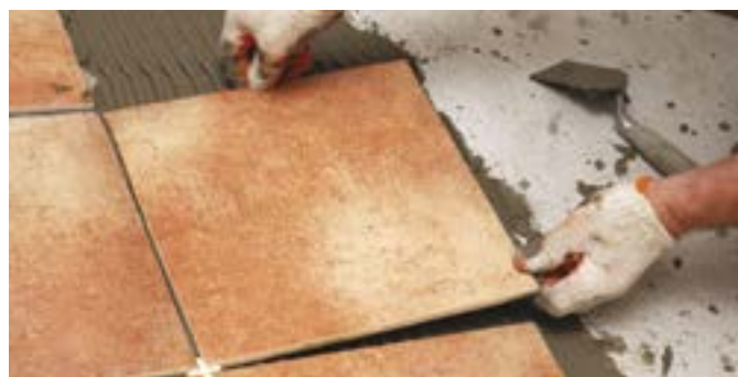
Klej do płytek nakładać na uprzednio zainstalowane płyty Promat przed nałożeniem na nie płytek.
