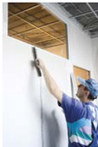
Nakładanie tynku na złącza przegród
