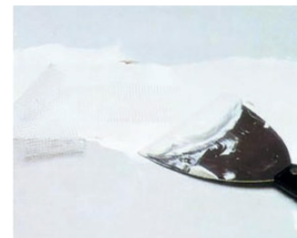
Nakładanie masy szpachlowej
