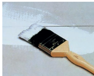
Przygotowanie złącza z pomocą gruntu
