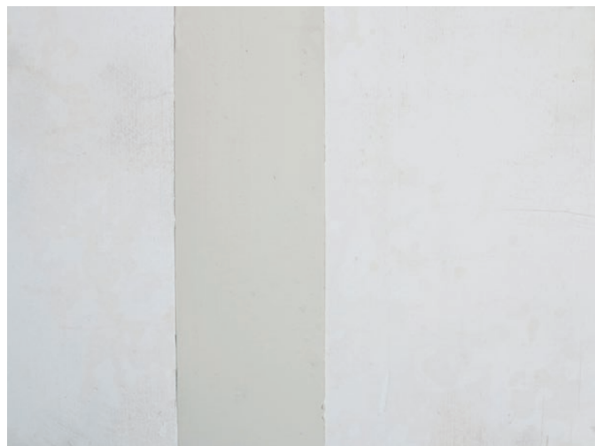
Złącze po finalnym wykończeniu pacą
