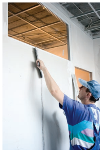
Nakładanie tynku na złącza przegród
