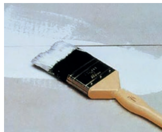
Przygotowanie złącza z pomocą gruntu
