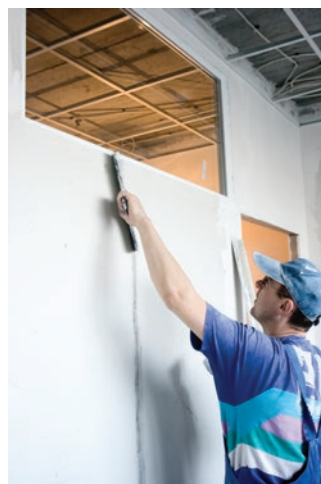
Nakładanie tynku na złącza przegród
