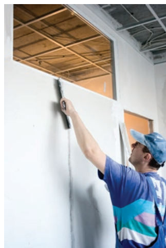
Nakładanie tynku na złącza przegród
