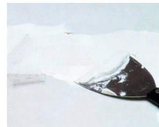
Nakładanie masy szpachlowej
