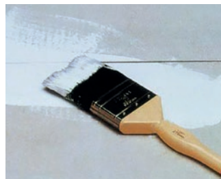
Przygotowanie złącza z pomocą gruntu
