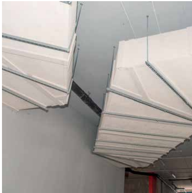
44 pav. PROMATECT®-L500 plokščių tvirtinimas prie šachtos sienų
