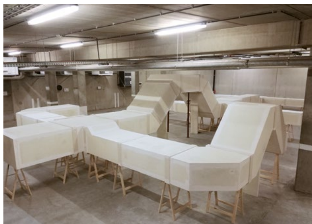
Messung von Druckverlusten an einem PROMATECT®-Leitungsnetz
