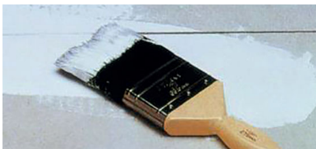
Preparazione del giunto con primer
