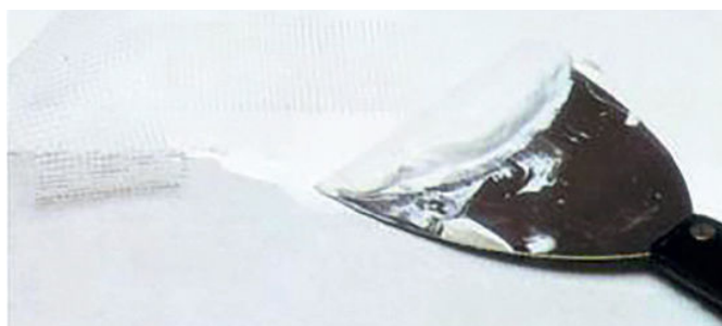
Applicazione di riempitivo per giunti
