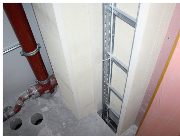
Figura 3: Schema tipologico con impianti di varia natura che possono essere valutati separatamente in accordo alla norma EN 1366-5 o EN 1366-1 in lastre PROMATECT®-L500 a protezione di impianti di qualsiasi natura o per rivestimento di condotte metalliche EI 120 (ve-ho i <->) S 500 Pa
