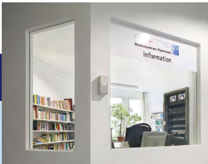
Einbaubeispiel für Promat®-Glasэлеmente in Wänden (385.45 mit PROMAGLAS® F1-30)
